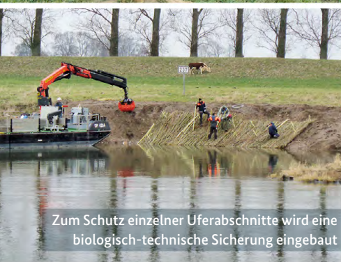
Ausführung der Maßnahmen vom Wasser aus
