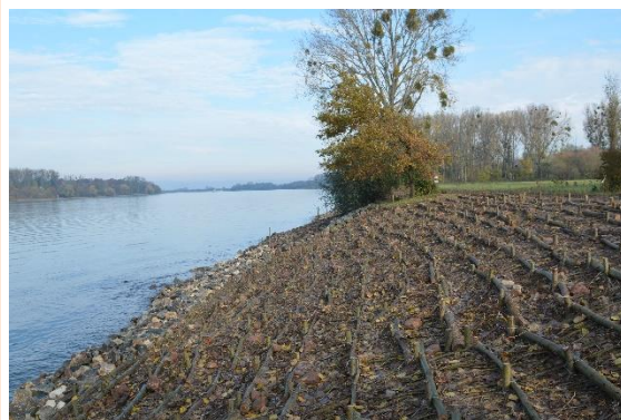
Abb. 7.3-1: Einbau von Weidenspreitlagen als Ufersicherung
