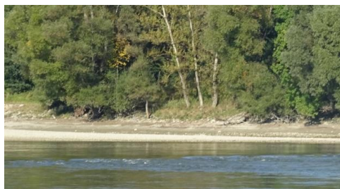
Abb. 2.2-1: Abgesenkte Buhne, die bei Abflüssen oberhalb von Niedrigwasser überströmt wird (hier durch bewegte Wasseroberfläche zu erkennen)
