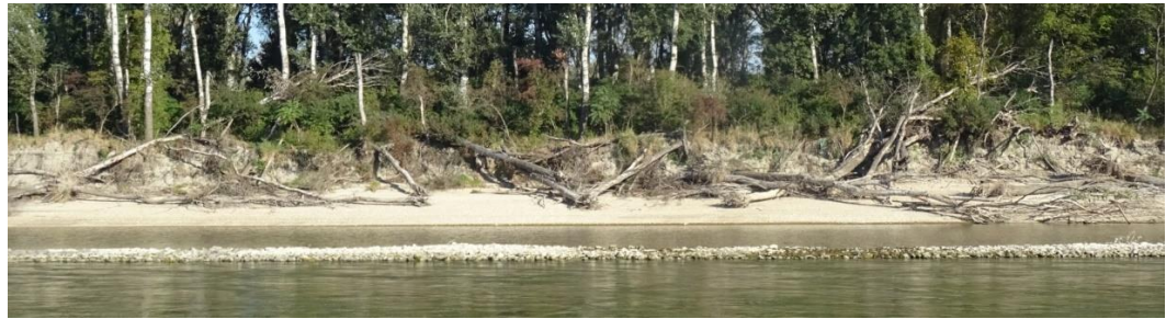
Abb. 8.3-1: Flachwasserzone hinter schützender Uferlinie aus teilweise rückgebauter Ufersicherung
