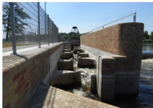
Abb. 5.2-1: Herstellung der Durchgängigkeit durch einen technischen Beckenpass
