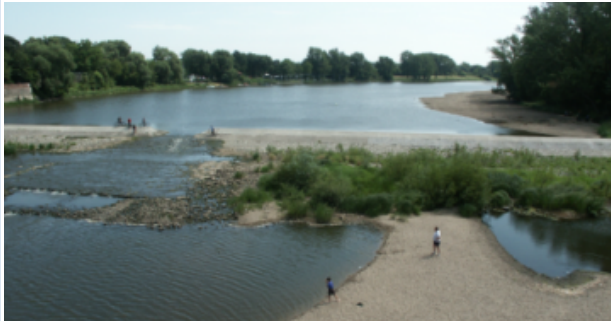
Abb. 5.1-1: Schleifung eines Querbauwerkes
