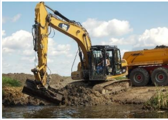
Abb. 2.1-1: Rückbau einer Buhne aus Wasserbausteinen
