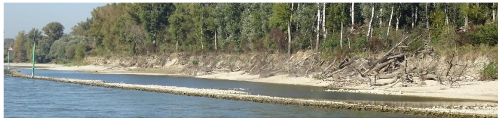
Abb. 7.2-1: Eigendynamische Entwicklung von Uferstrukturen hinter teilweise rückgebauter Ufersicherung
