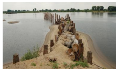
Abb. 2.2-2: Totholzuhne als alternativ technisch-biologisches Regulierungsbauwerk
